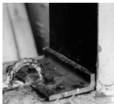
写真-1 提案した定着工法
