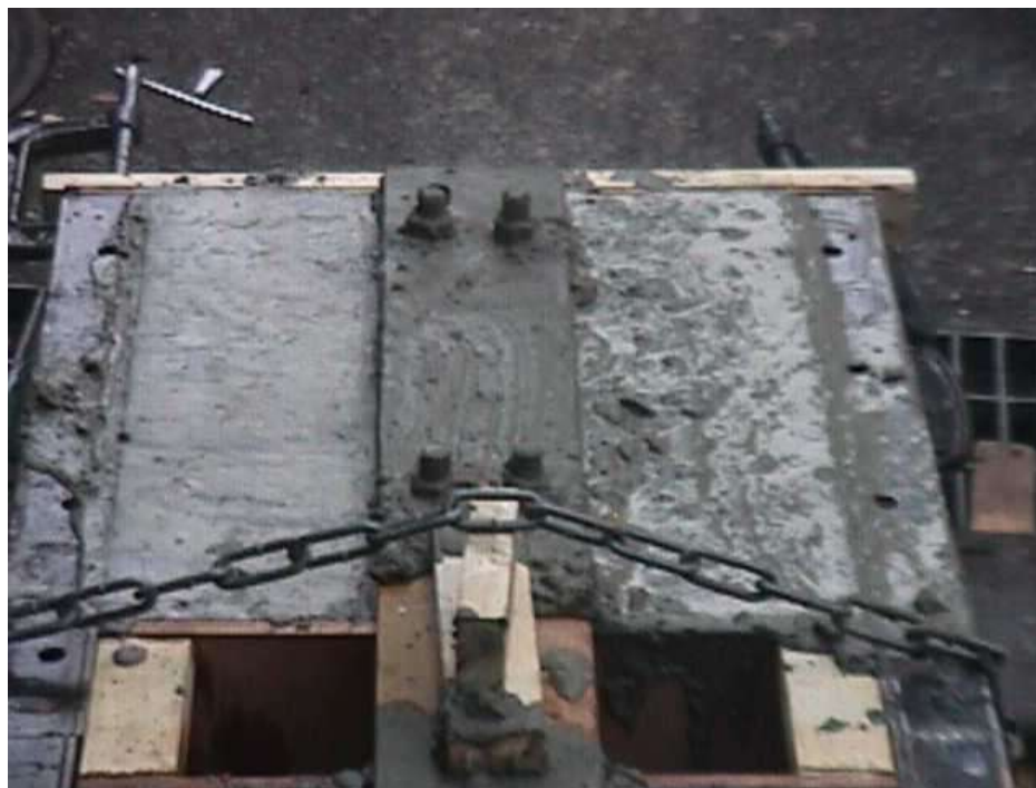
写真 9-4 台座部打設
