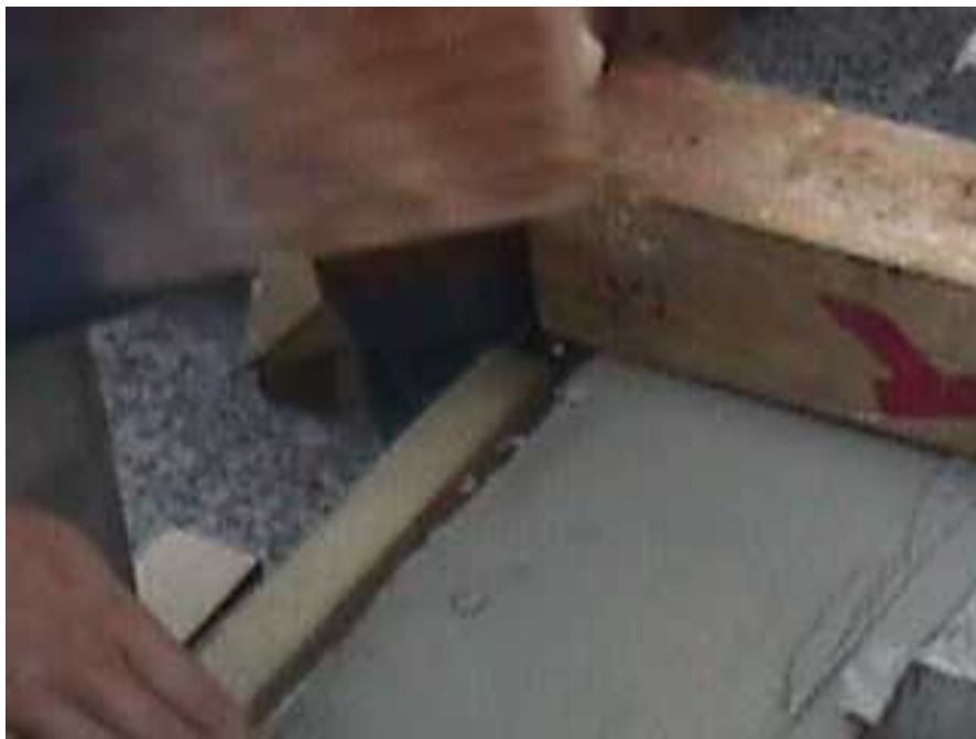
写真 9-8 石膏による面出し
