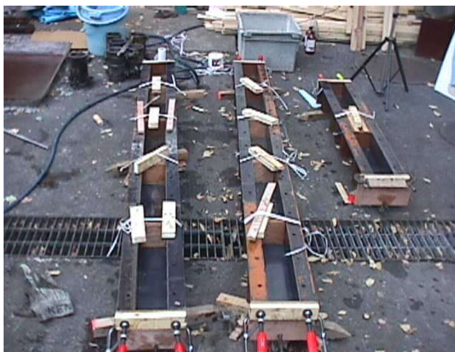
写真 9-3 柱部型枠
