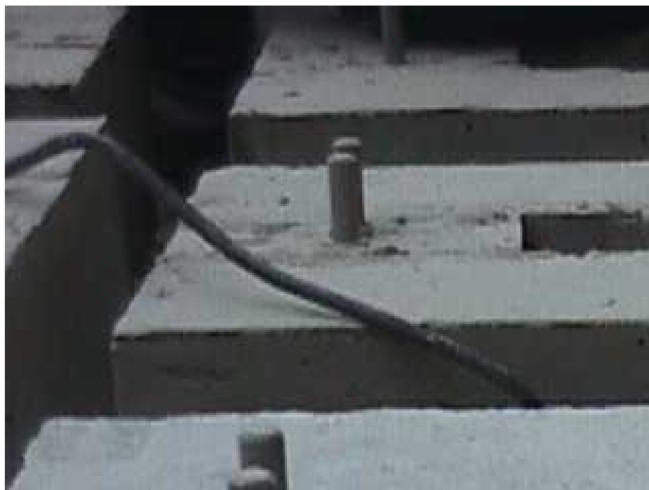
写真 9-7 台座部研磨後（下地処理工）
