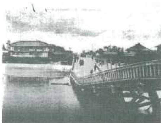
(A) 枇杷島橋の被害
