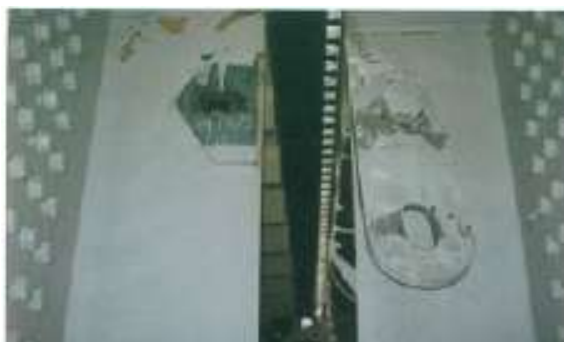
図 2.14 桁間連結装置の被害（ピンの破損） 2.2)
