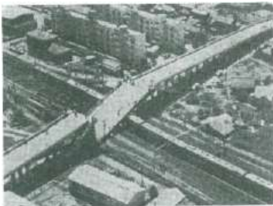
(A) 新潟駅東跨線橋の被害
