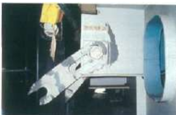
図 2.16 桁間連結装置の被害（連結板の破損） 2.2)
