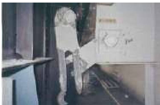
図 2.16 桁間連結装置の被害（連結板の破損） 2.2)
