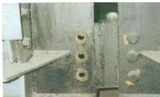
図 2.14 桁間連結装置の被害（ピンの破損） 2.2)
