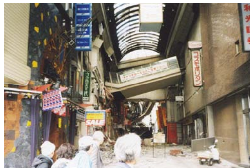
写真-1 阪神大震災における被災状況
