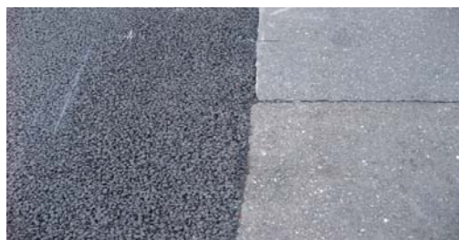
写真-1 低騒音舗装道路(左)と通常舗装道路(右)
