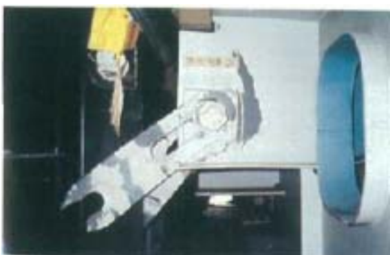
図-2.16 桁間連結装置の被害（連結板の破損） 2.2)
