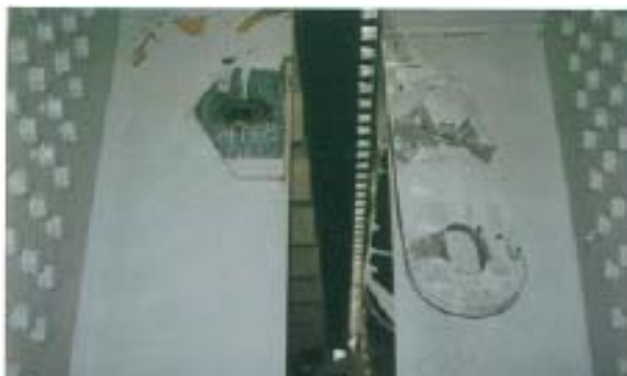
図-2.14 桁間連結装置の被害（ピンの破損） 2.2)
