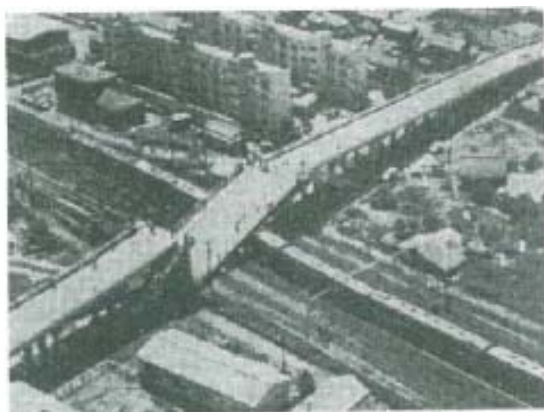
(A) 新潟駅東跨線橋の被害
