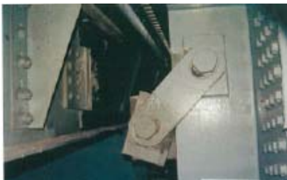
図-2.15 桁間連結装置の被害（取り付け金具の破損） 2.2)
