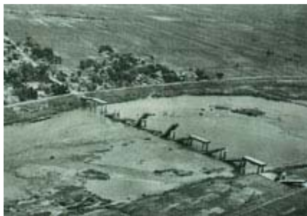
図-2.6 福井地震での被害(中角橋) 2.2)
