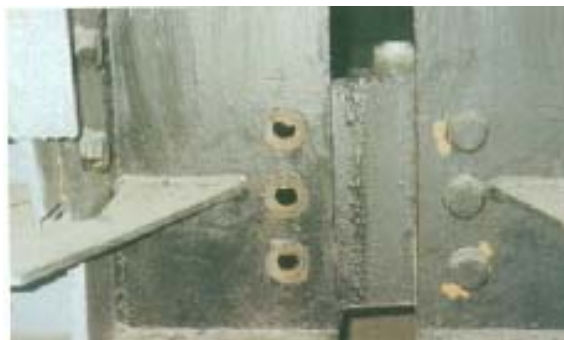
図-2.14 桁間連結装置の被害（ピンの破損） 2.2)
