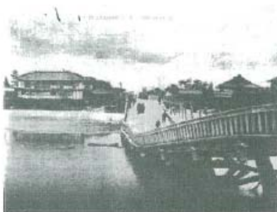
(A) 枇杷島橋の被害
