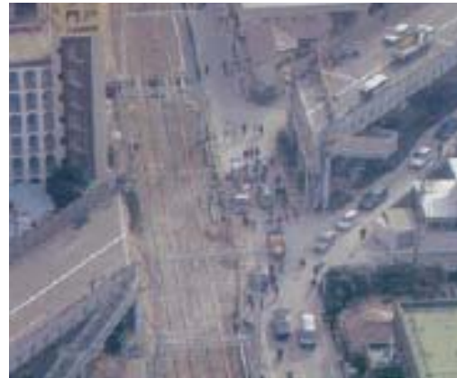
図-2.11 兵庫県南部地震による被害②
