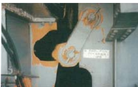
図-2.15 桁間連結装置の被害（取り付け金具の破損） 2.2)
