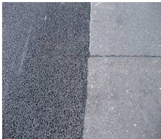
写真-4 低騒音舗装道路(左)と通常舗装道路(右)
