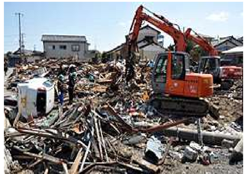
がれき撤去の様子
