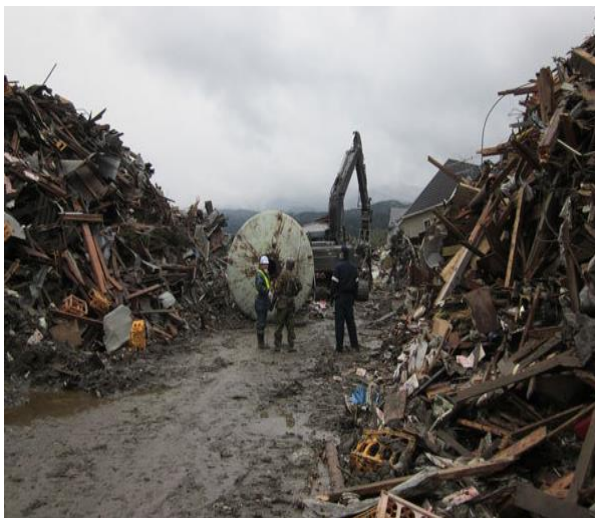
写真-1 東日本大震災時の道路啓開作業 4)
