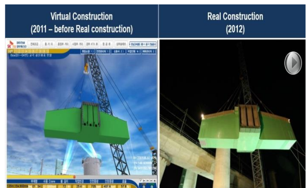
図-4 BIM使用時における仮想施工と実施工との比較 6)
