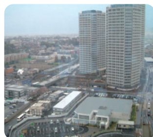
二子玉川東地区再開発事業の見学
