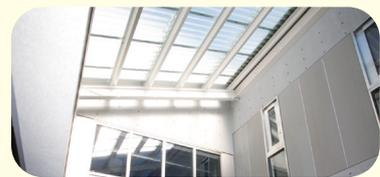
建物の中央部は吹き抜けにして、天窓から落ちる自然光を地階まで取り込むよう設計
