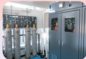
研究に欠かせない高圧ガスボンベは、4Fのボンベ室で一括管理される。安全面でも万全の体制を整えている。
