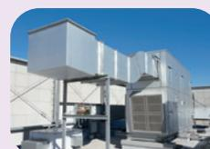
外気と室内排気の間で熱交換を行う外調機が並ぶ
