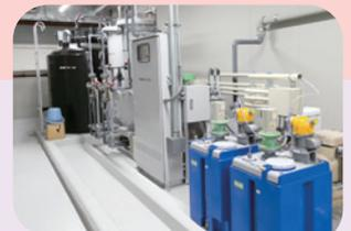
研究や実験で使用した薬品とその排水などは建物内の廃液処理施設で一括処理し、浄化後一般排水としている。
