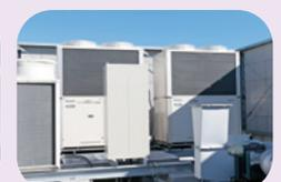
ガスエンジン駆動式のエアコン、ガスヒートポンプが2台
