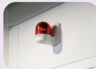
高圧ガスを使う研究室が多い新6号館は、各部屋の扉上部にガス漏れ警報器を設置。異常が検知されると1階の事務室だけでなく、1号館の警備室にも通報される。
