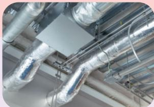
通常より30cm程高い二重床のため天井は、圧迫感を緩和するよう、すべて配管がむき出しのスケルトン構造になる。
