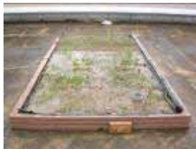
情報メディアセンター屋上 ビオトープパッケージ
