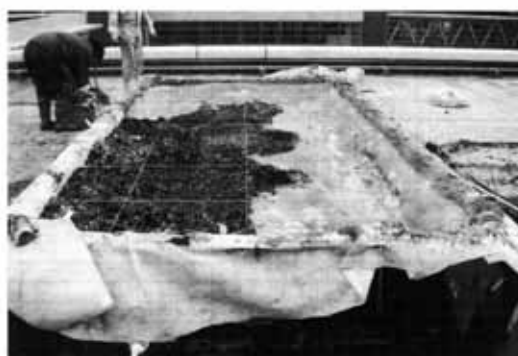
写真-3 土壌設置後の様子
