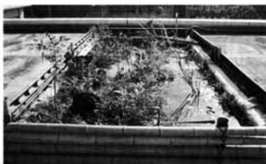
写真-4 ピオトープパッケージ施工完了後の様子
