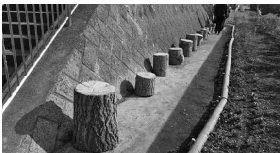
写真6 丸太ベンチの設置
