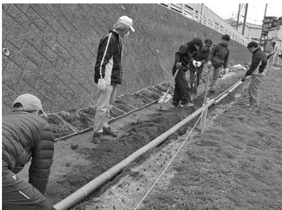
写真5 園路の見切り材の設置
