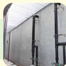
教室の外側は地面を振り下げたドライエリア。地下でも外光が射しこみ、通風も確保しています。
