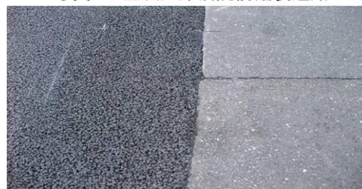
写真-2 低騒音舗装道路(左)と通常舗装道路(右)
